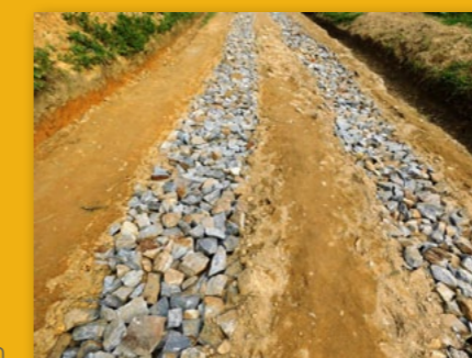
Réparation de la piste principale © HELPSIMUS
